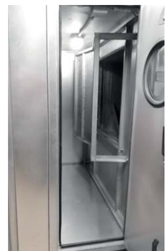
Abb. 9) Prallplatte im bestehenden Klimagerät
