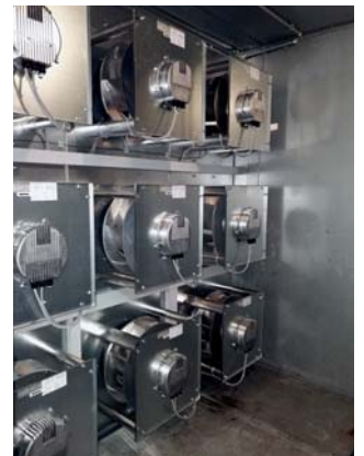
Abb. 11) Druckseite der ECFanGrid
