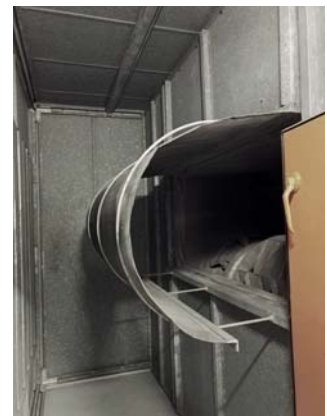
Abb. 2) Prallschirme sind unnötige Druckverluste
