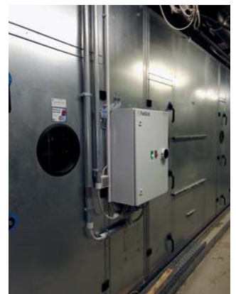
Abb. 12) Schaltschrank der ECFanGrid
