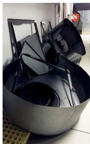
Abb. 8) Ausbau des alten Ventilators
